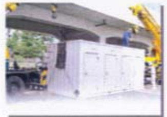
貸し倉庫の設置
