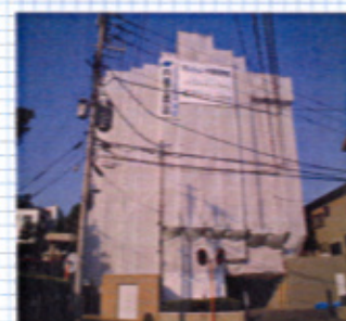
リノベーション中のマンション
