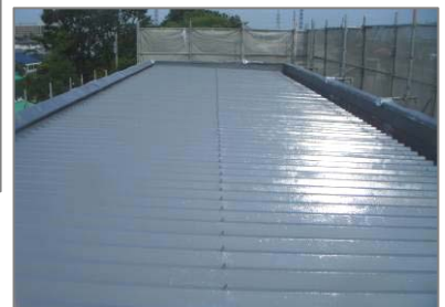
＜東京都府中市＞ 食品会社倉庫屋根 倉庫内の温度上昇の低減を図る 為に遮熱塗装を施しました
